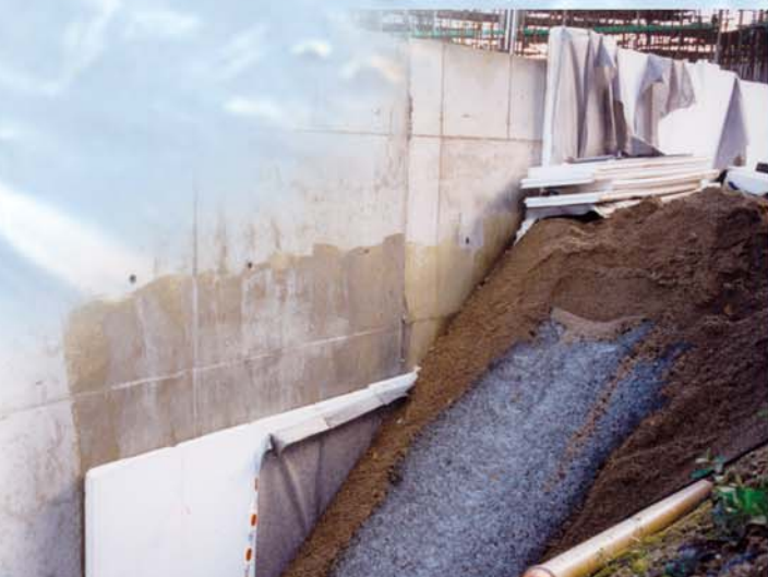
Efter VANDEX behandlingen er reaktionen mellem den frie kalk, vandet og VANDEX additiverne startet. VANDEX trænger ind i kapillarsystemet og blokerer det.
