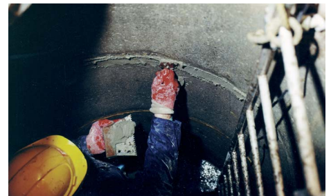
3. Forsegling af utætte støbeskel med VANDEX RAPID M
