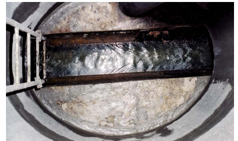
6. Det renoverede mandehul
