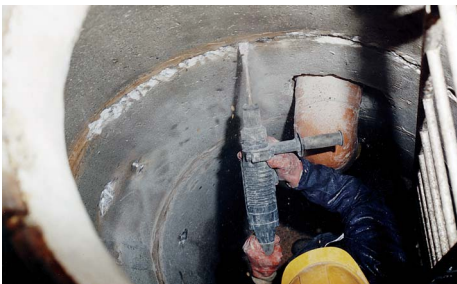
1. Udhugning af skader til sund beton
