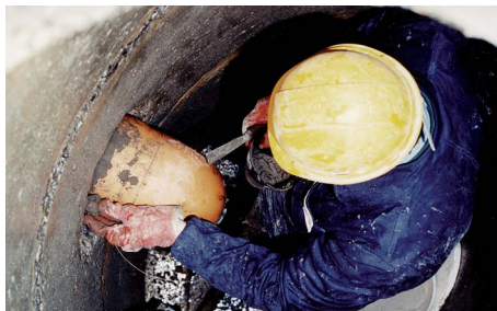
2. Lukning af skadet rørgennemføring og samlinger
