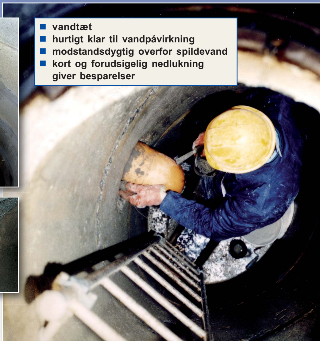
Hurtig og effektiv vandtætning af mandehul med VANDEX RAPID produkter
