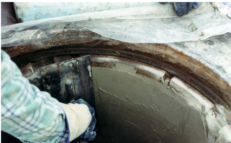
4. Reprofilering af det øverste af hullet med VANDEX RAPID S
