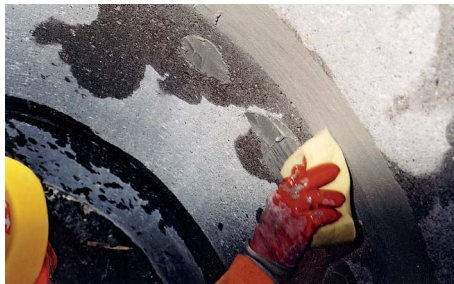
5. Udglatning af VANDEX RAPID S med en let fugtig svamp
